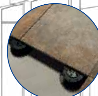
Укладка на опоры Posa sopraelevata Raised installation
