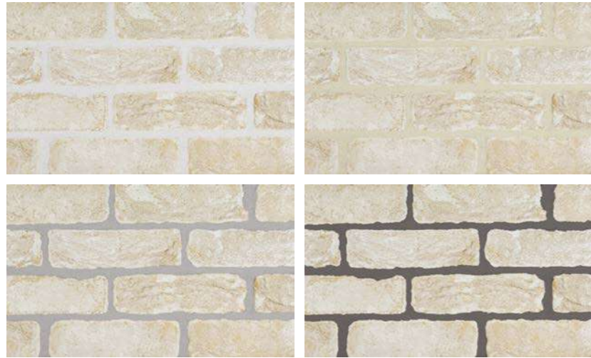
Effetto colore malta sulla percezione del colore del mattone. Mortar color effect on the perception of the brick color.
