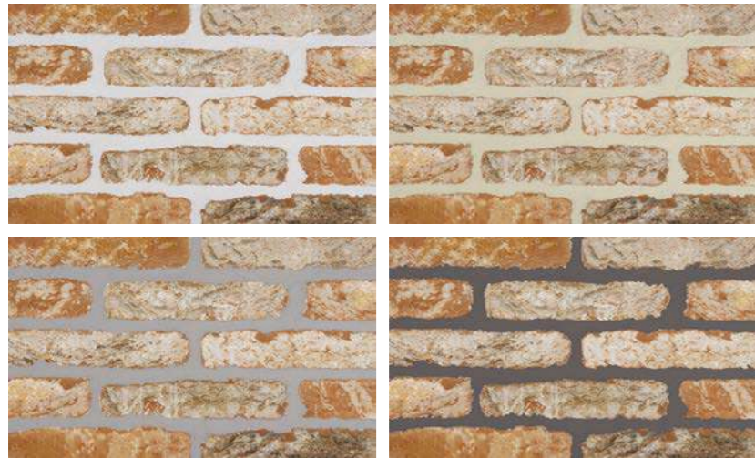
Effetto colore malta sulla percezione del colore del mattone. Mortar color effect on the perception of the brick color.
