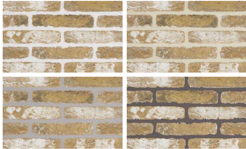
Effetto colore malta sulla percezione del colore del mattone. Mortar color effect on the perception of the brick color.
